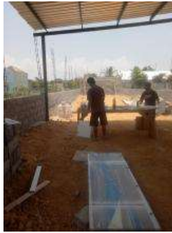
Gambar 3. Eksisting Sumber: dokumentasi penulis, 2019
