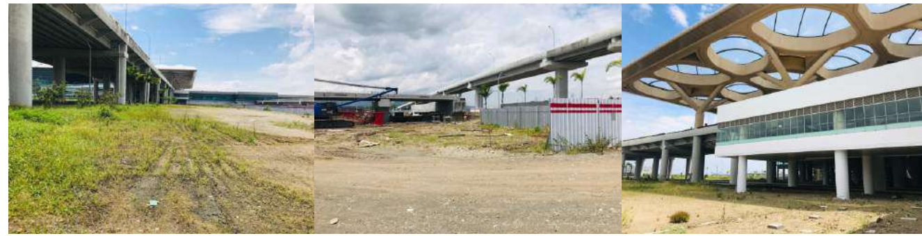
Fly over sebelah selatan site menuju terminal kedatangan
