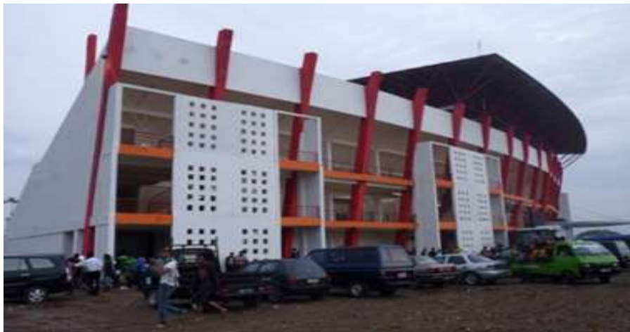
Gambar 4. Area parkir kendaraan tidak tertata
