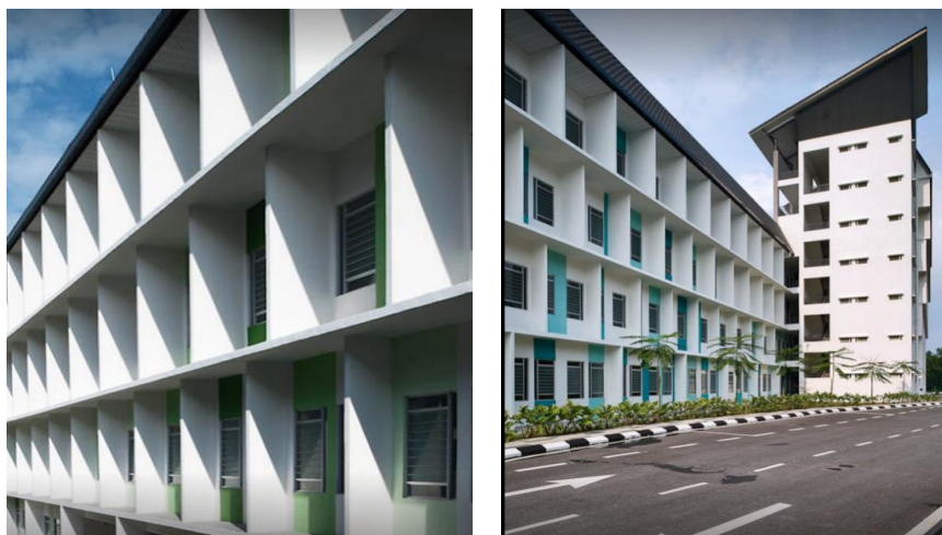
Gambar 2. Ilustrasi Shading dan Lanscaping Untuk Menunjang Kenyamanan Termal Bangunan Sekolah
