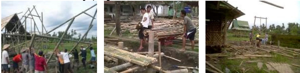
Gambar.2. Proses Pembangunan yang Dilakukan Secara Gotongroyong
