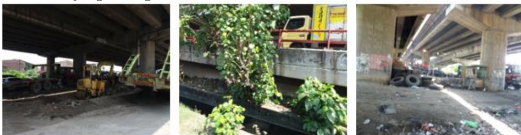
Gambar 5. Kondisi ruang bawah jalan layang
