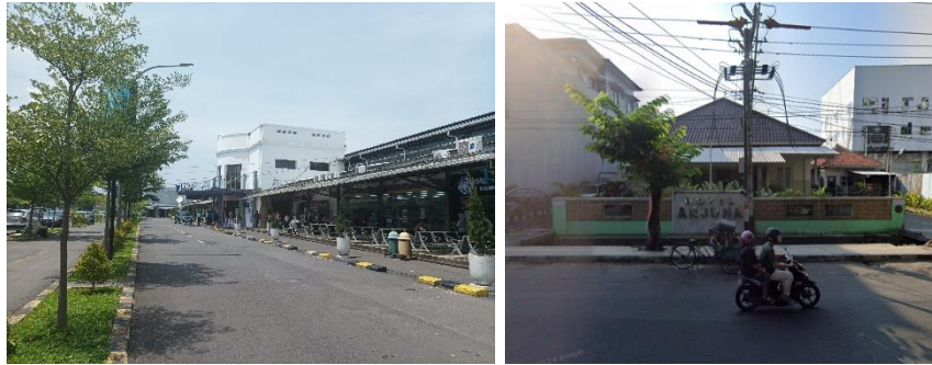
Gambar. 17. Bangunan Cagar Budaya Stasiun Semarang Poncol dan Bangunan Hotel Arjuna di Kawasan Stasiun Semarang Poncol Sumber: Dokumentasi Penulis, 2025
