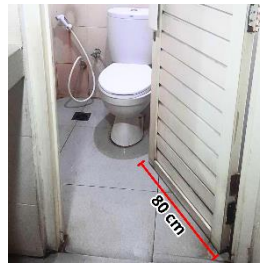
Gambar.10. Dimensi Lebar Pintu Toilet
