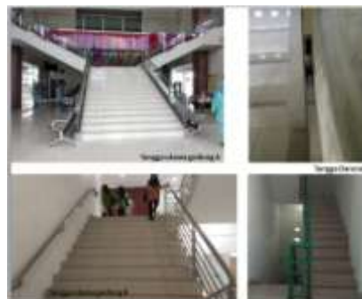
Gambar 4. Kondisi Tangga di Kampus Terpadu UNISA
