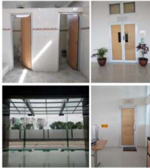
Gambar 2. Kondisi Pintu di Kampus Terpadu UNISA
