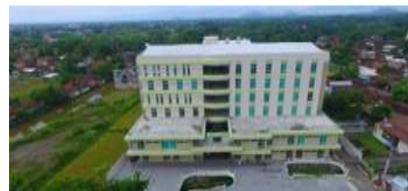
Gambar 2. Gedung A Kampus Terpadu UNISA (Sumber : www.unisayogya.ac.id )
