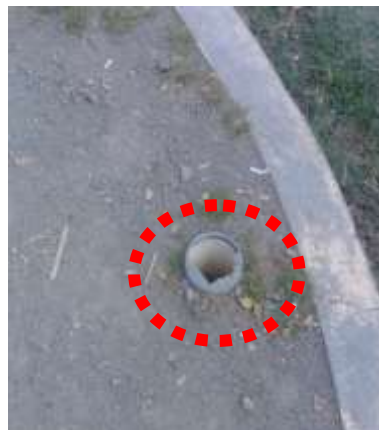
Gambar.8 Lubang dengan pipa menonjol di area Wahana mainan anak
