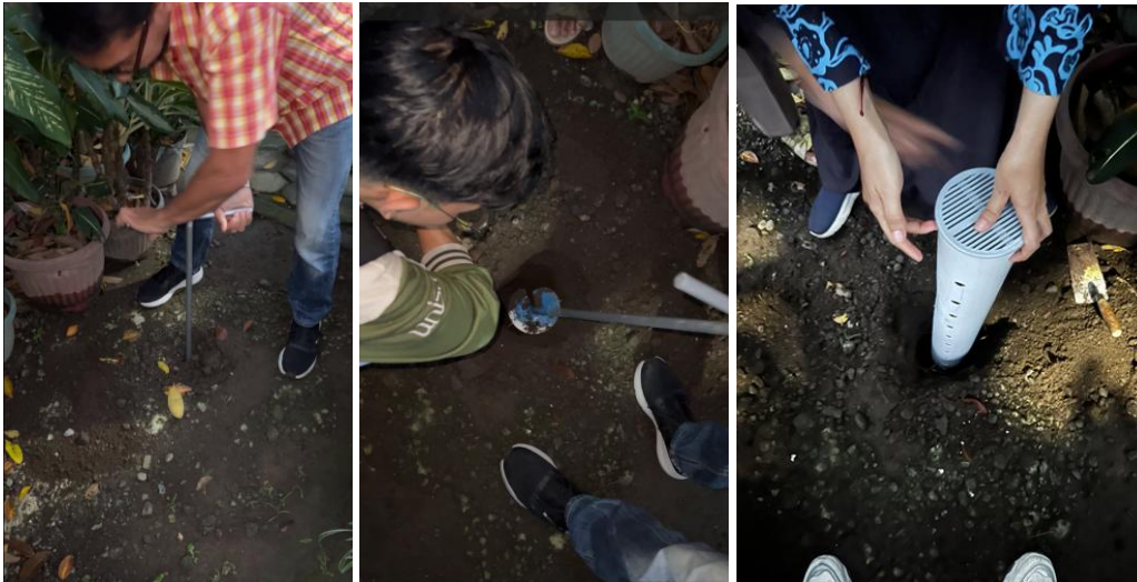
Gambar 4. Proses pembuatan lubang resapan biopori
